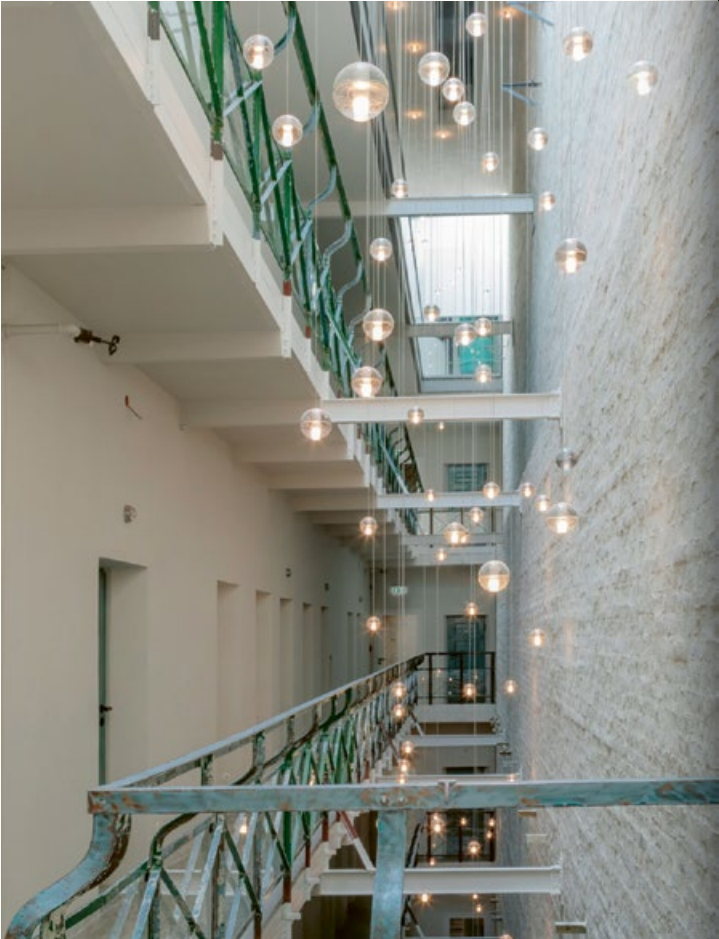
Das Atrium verbindet die vier Bestands-geschosse mit der neu aufgesetzte Penthouse-Etage
